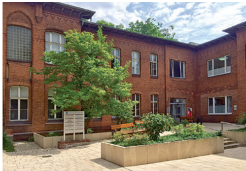
Eingang über Müllerstraße 56-58 (rotes Backsteingebäude) PHYSIO-DEUTSCHLAND im Gebäude B (Erdgeschoss)
